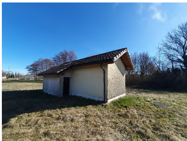
Figure 9: Situation du Puits du l'Ezilière, à Gimel.
