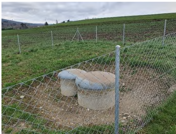
Figure 17: Situation du Puits des Grandes Rayes.
