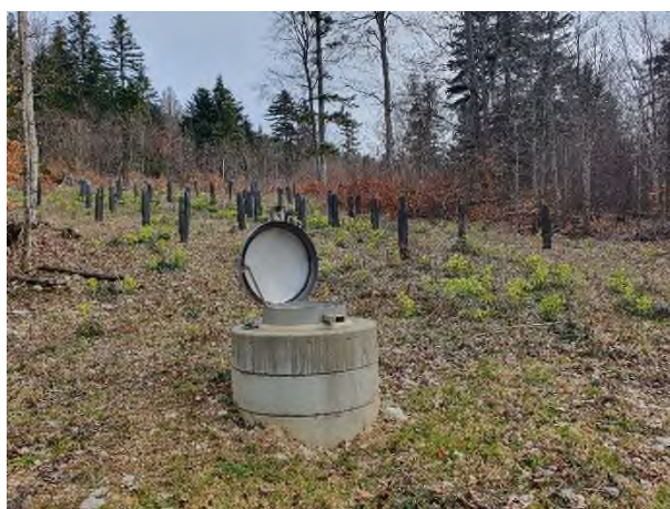
Figure 14: Source de la Grillette, chambre de captage.
