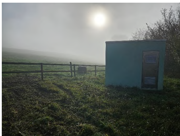
Figure 10: Situation du Puits du Bugnon, à Longirod.
