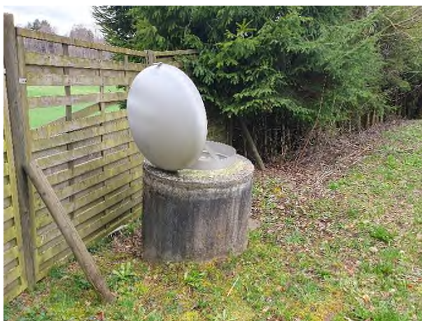
Figure 16: Source du By, chambre de captage.
