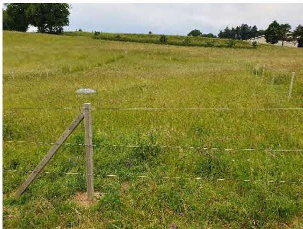
Figure 6: Source des Vernes, chambre de captage.
